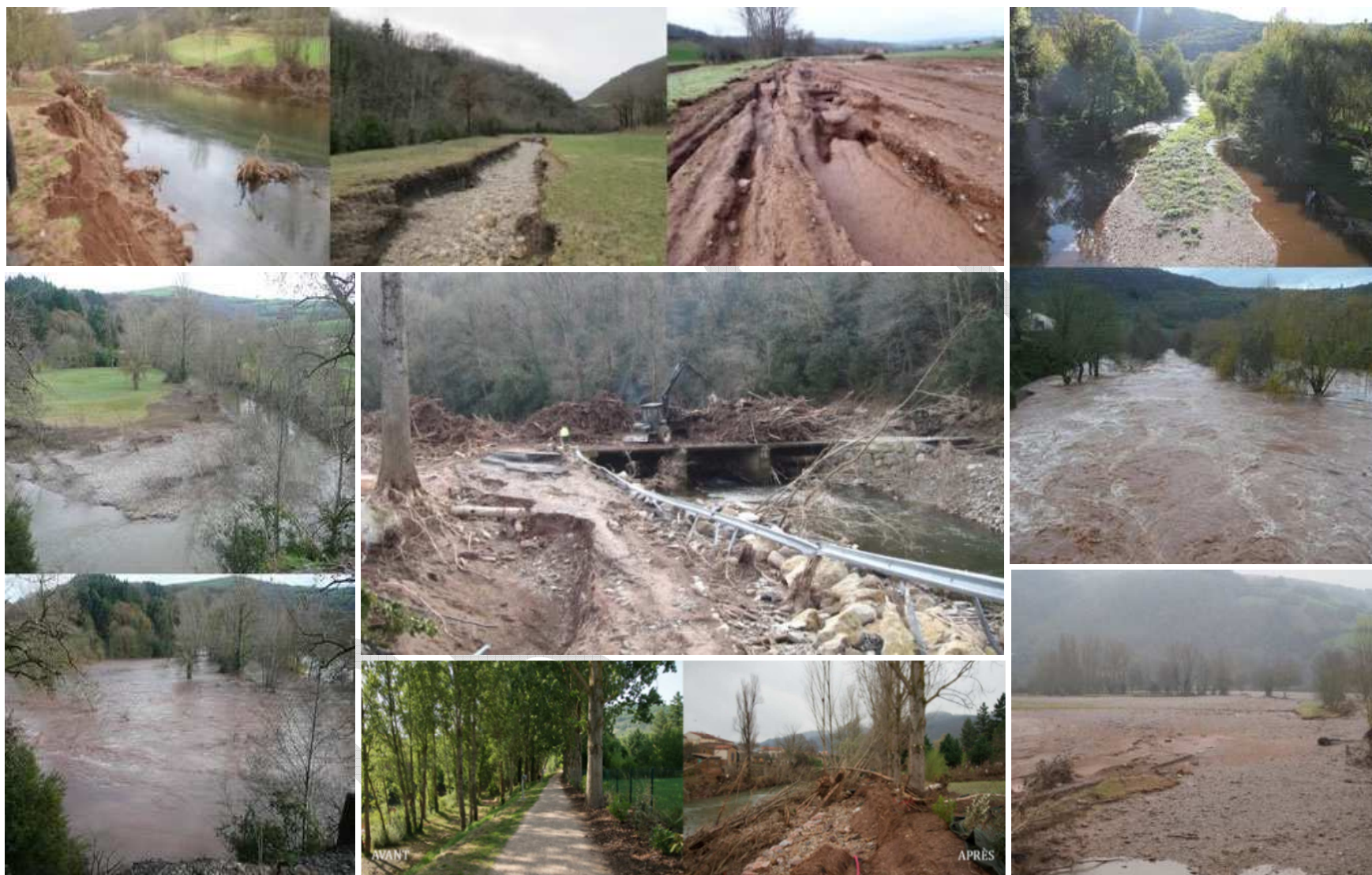
Figure 3 : Illustrations de dégâts des inondations sur le bassin versant TSDR
