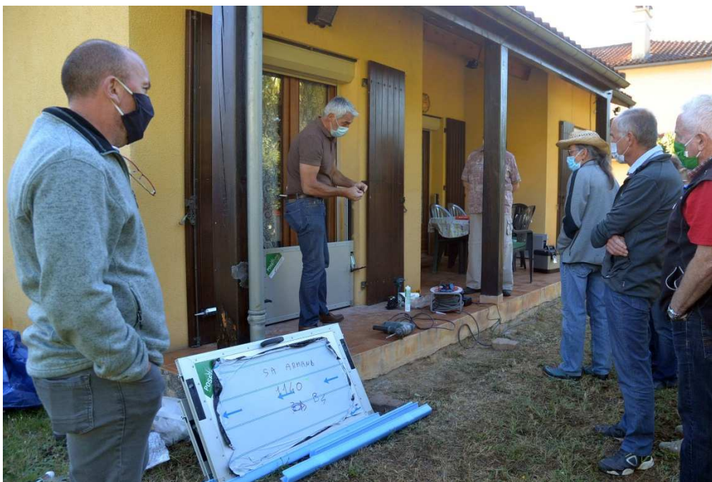
Figure 20 : Pose de batardeaux à Saint-Affrique dans le cadre du PAPI d'Intention
